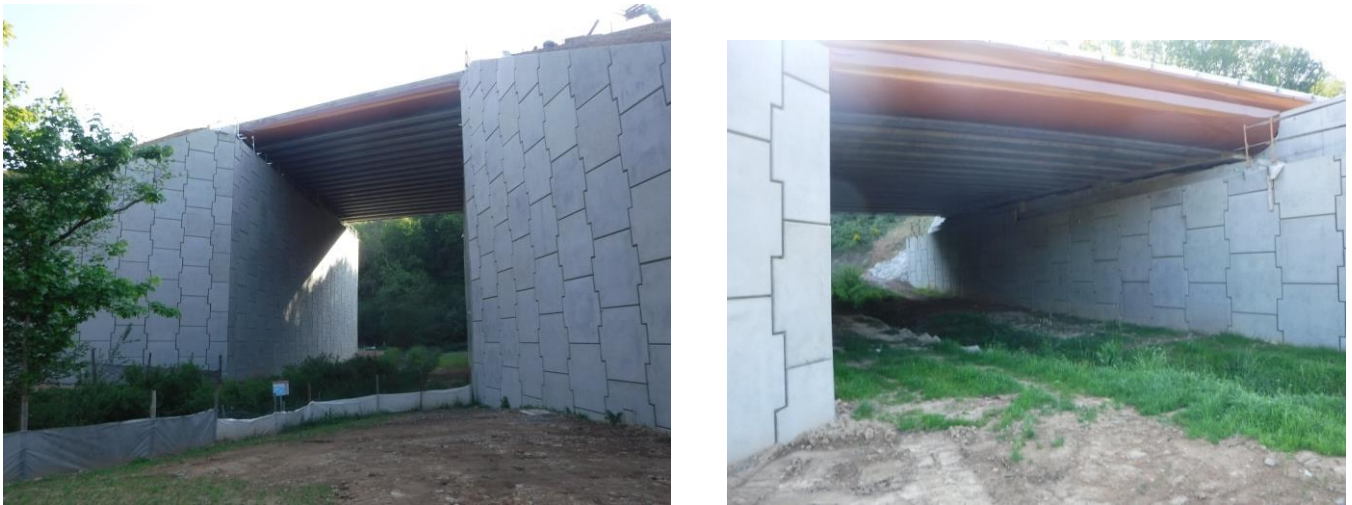
Figure 15 : Photo du PI4 (à gauche) et du PI5 (à droite) terminés
